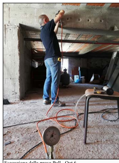
Esecuzione della prova Pull - Out 6.
