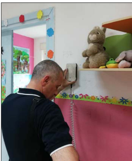
Ricostruzione schemi strutturali con ausilio dello strumento "Pachometro". Rilevati nel pilastro P57 sei ferri longitudinali Ø14 e staffe Ø6/13
