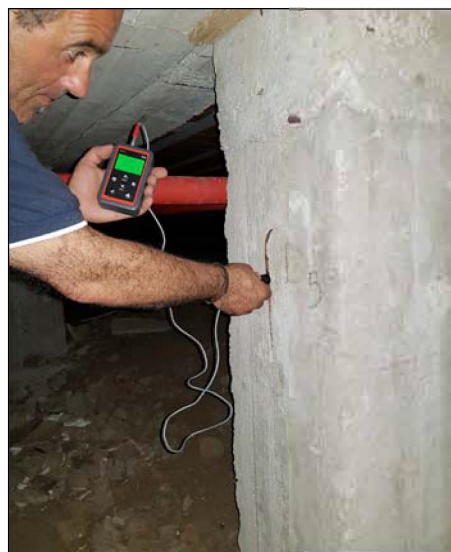
Esecuzione della prova durometrica sui ferri del pilastro P58.
