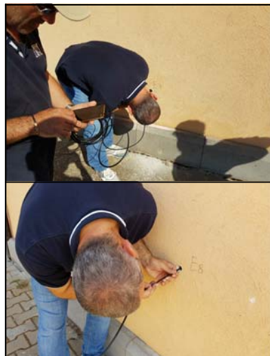
Esecuzione delle prove endoscopiche 7 e 8
