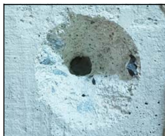
Particolare dell'estrazione prova Pull - Out 16.
