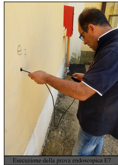
Esecuzione della prova endoscopica E7
