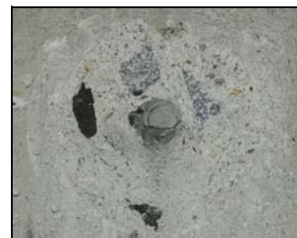
Particolare dell'estrazione prova Pull - Out 2.
