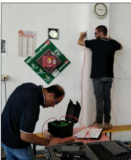
Esecuzione della prova ultrasonica sul pilastro P64.
