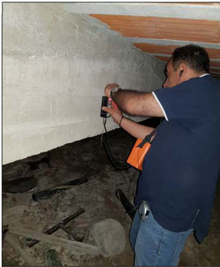
Ricostruzione schemi strutturali con ausilio dello strumento "Pachometro". Rilevati nella campata della trave T3 4 ferri Ø20. Agli appoggi si sono riscontrati 3 ferri Ø20
