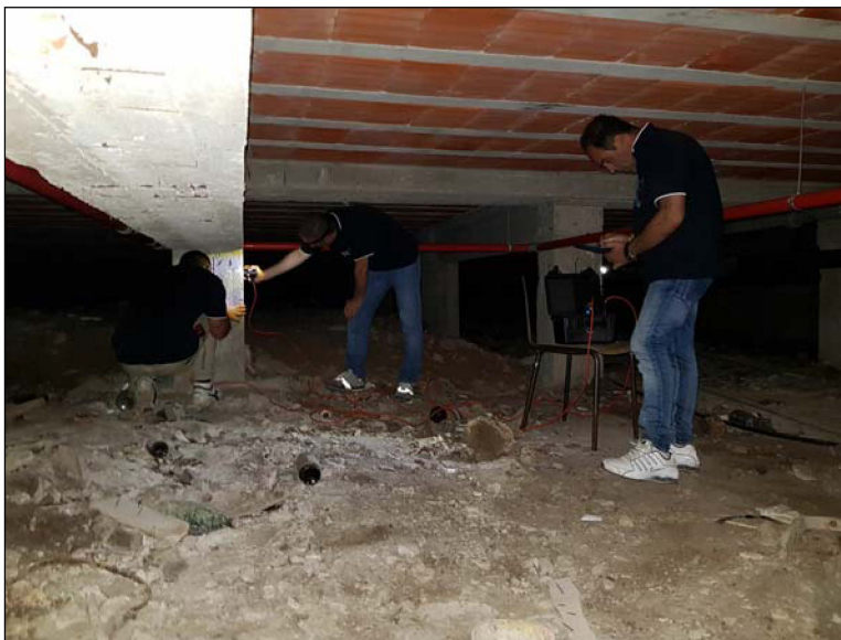
Esecuzione delle prove ultrasoniche e sclerometriche sul pilastro P50.
