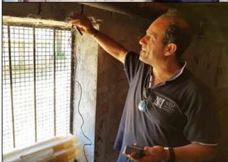
Esecuzione della prova durometrica sulle trave T5 e T7.
