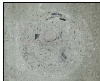
Particolare dell'estrazione prova Pull - Out 3.
