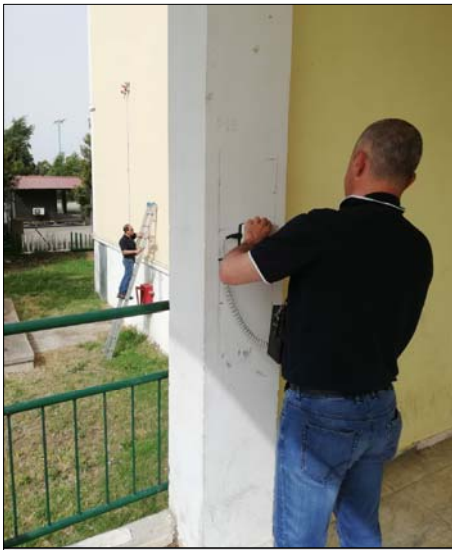
Ricostruzione schemi strutturali con ausilio dello strumento "Pachometro". Rilevati nel pilastro P13 sei ferri longitudinali \varnothing 14-16 e staffe \varnothing 10/13
