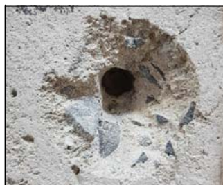
Particolare dell'estrazione prova Pull - Out 14.
