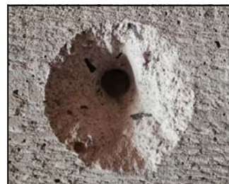
Particolare dell'estrazione prova Pull - Out 6.
