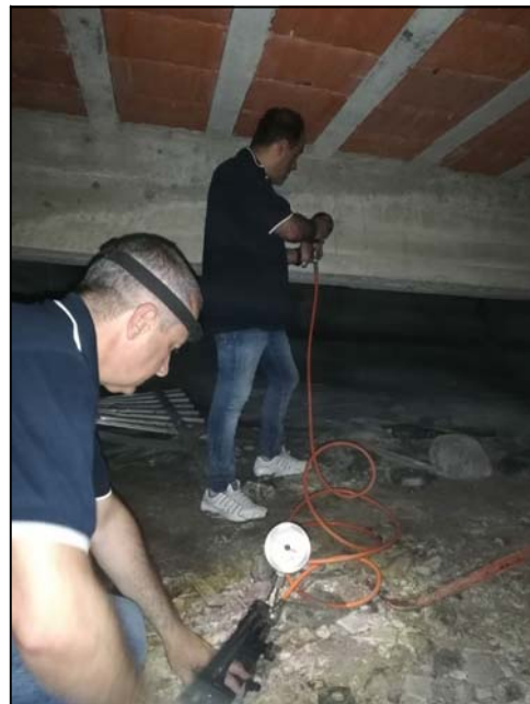
Esecuzione della prova Pull - Out 1.
