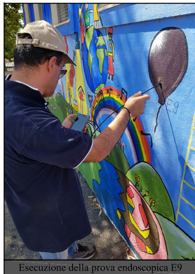
Esecuzione della prova endoscopica E9
