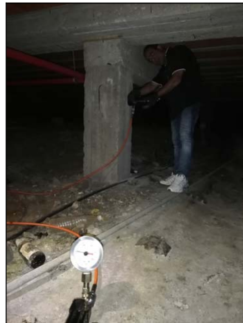
Esecuzione della prova Pull - Out 3.
