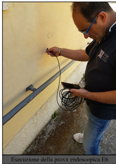
Esecuzione della prova endoscopica E6
