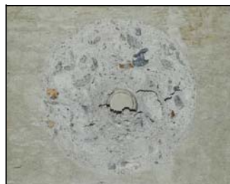
Particolare dell'estrazione prova Pull - Out 1.
