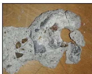
Cono estratto dalla prova Pull - Out 4 (pressione di estrazione 109 bar RcK 42,2 N/mm 2 ).
