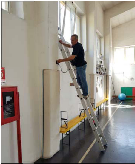
Ricostruzione schemi strutturali con ausilio dello strumento "Pachometro". Rilevati nel pilastro P35 otto ferri longitudinali Ø18 sul lato del pilastro all'interno della palestra e tre Ø16 su quello esterno. Rilevate staffe Ø6-8/12
