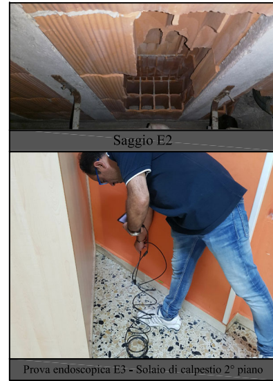
Prova endoscopica E3 - Solaio di calpestio 2° piano
