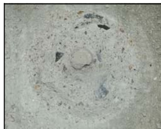
Particolare dell'estrazione prova Pull - Out 4.
