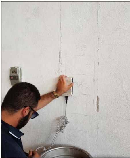
Ricostruzione schemi strutturali con ausilio dello strumento "Pachometro". Rilevati nel pilastro P19, quattro ferri longitudinali \varnothing 16 e staffe \varnothing 8/15
