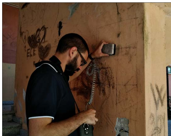
Ricostruzione schemi strutturali con ausilio dello strumento "Pachometro". Rilevati nel setto murario in calcestruzzo armato, 13+13 ferri verticali Ø12 e staffe Ø6/25
