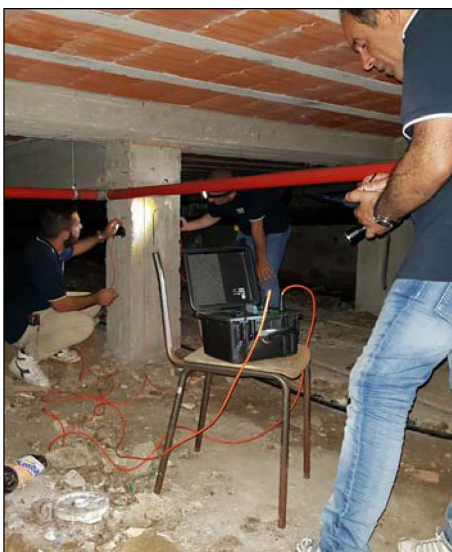
Esecuzione delle prove ultrasoniche e sclerometriche sul pilastro P58.
