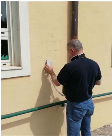
Ricostruzione schemi strutturali con ausilio dello strumento "Pachometro". Rilevati nei pilastri P16 e P17 sei ferri longitudinali \varnothing 12 e staffe \varnothing 6/13
