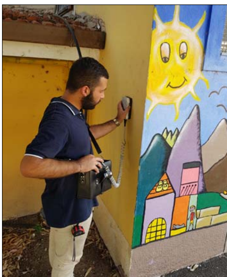
Ricostruzione schemi strutturali con ausilio dello strumento "Pachometro". Rilevati nel pilastro P19 sei ferri longitudinali \varnothing 12 e staffe \varnothing 6-7/14
