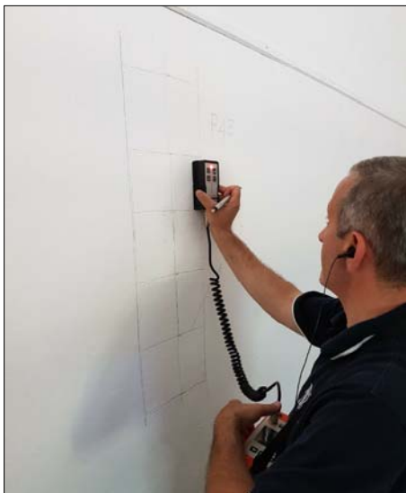
Ricostruzione schemi strutturali con ausilio dello strumento "Pachometro". Rilevati nel pilastro P43, sei ferri longitudinali \varnothing 16 e staffe \varnothing 6/15
