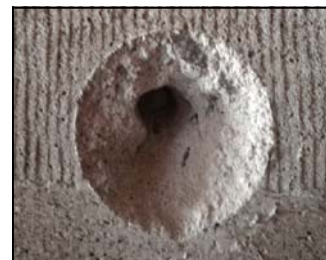
Particolare dell'estrazione prova Pull - Out 5.
