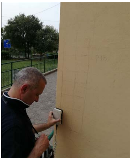
Ricostruzione schemi strutturali con ausilio dello strumento "Pachometro". Rilevati nel pilastro P18 sei ferri longitudinali \varnothing 12 e staffe \varnothing 6-7/15
