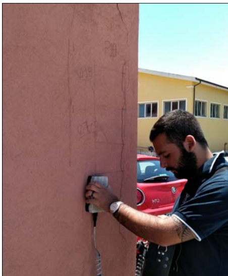
Ricostruzione schemi strutturali con ausilio dello strumento "Pachometro". Rilevati nel pilastro P10, sei ferri longitudinali \varnothing 16 e staffe \varnothing 6/16
