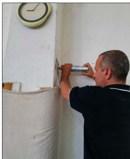
Prove sclerometriche sul pilastro P64.
