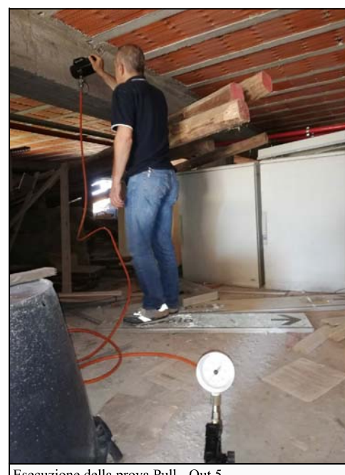
Esecuzione della prova Pull - Out 5.
