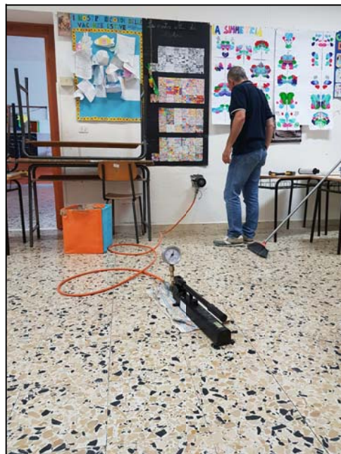
Esecuzione della prova Pull - Out 14.
