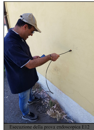
Esecuzione della prova endoscopica E12
