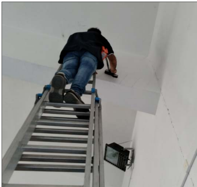
Ricostruzione schemi strutturali con ausilio dello strumento "Pachometro". Rilevati nella trave T1 (corpo palestra), quattro ferri longitudinali \varnothing 20 e staffe \varnothing 8/20 ( passo 15 all'infittimento)
