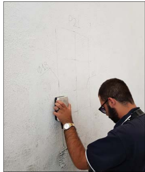
Ricostruzione schemi strutturali con ausilio dello strumento "Pachometro". Rilevati nel pilastro P21, sei ferri longitudinali \varnothing 20 e staffe \varnothing 8/20
