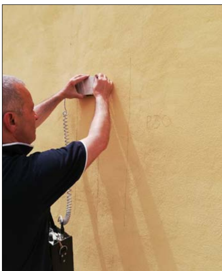
Ricostruzione schemi strutturali con ausilio dello strumento "Pachometro". Rilevati nel pilastro P30 sei ferri longitudinali \varnothing 10 e staffe \varnothing 6/14
