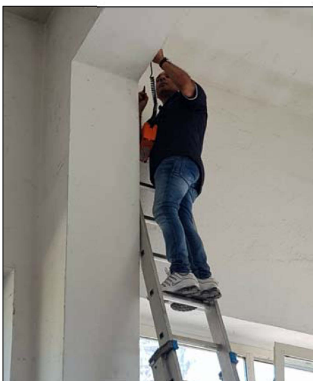
Ricostruzione schemi strutturali con ausilio dello strumento "Pachometro". Rilevati agli appoggi della trave T10 3 ferri Ø20 e staffe con passo 25-30.
