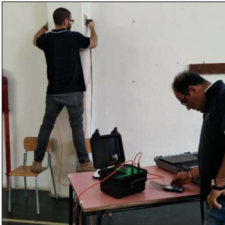
Esecuzione della prova ultrasonica sul pilastro P35.
