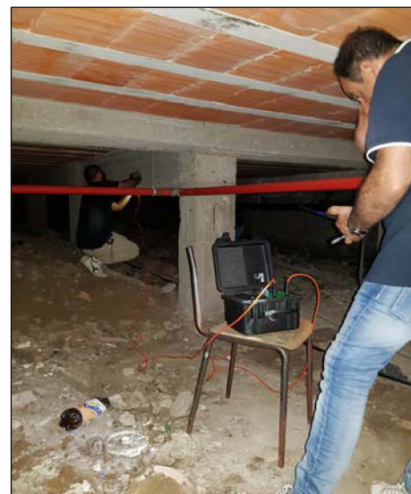
Esecuzione delle prove ultrasonica e sclerometriche sulla trave T3.
