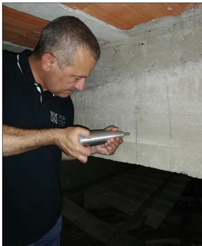
Esecuzione della prova sclerometrica sulla trave T2.
