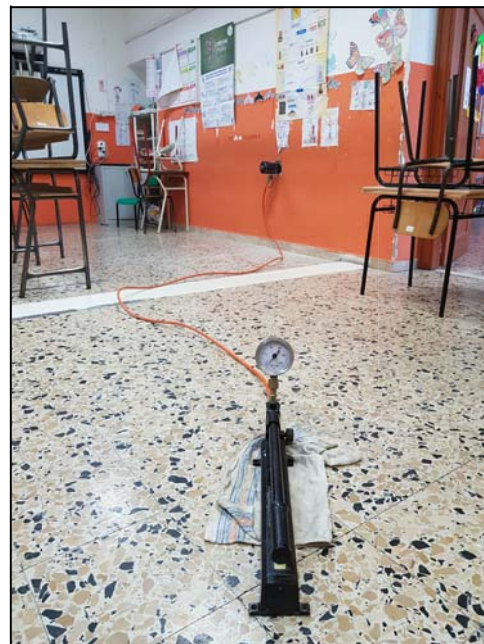
Esecuzione della prova Pull - Out 15.
