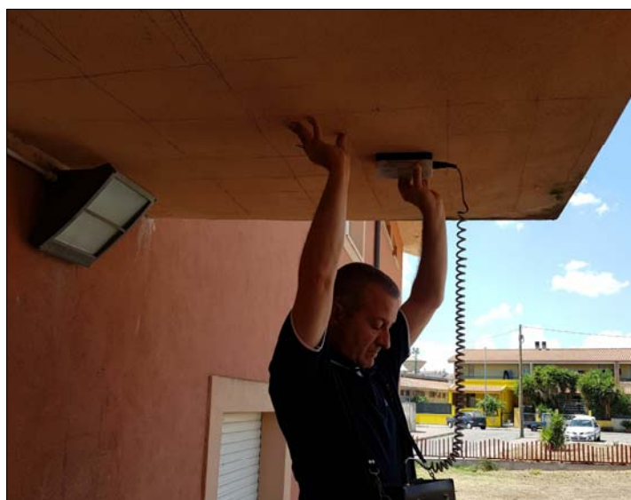
Ricostruzione schemi strutturali con ausilio dello strumento "Pachometro". Rilevati nella soletta armata del 3° pianerottolo (scala esterna), venti ferri longitudinali Ø16 e staffe Ø11/20
