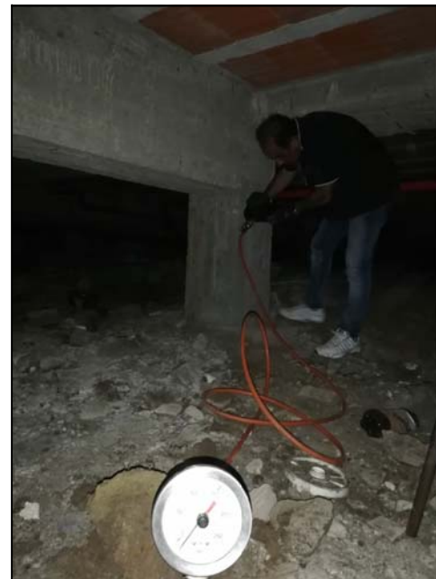
Esecuzione della prova Pull - Out 2.
