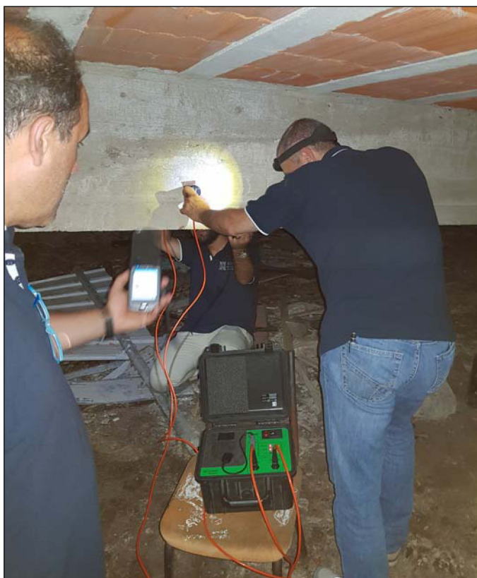
Esecuzione della prova ultrasonica sulla trave T2.
