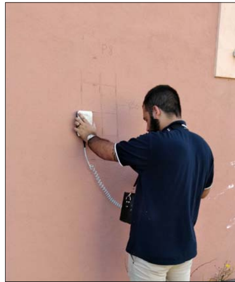
Ricostruzione schemi strutturali con ausilio dello strumento "Pachometro". Rilevati nel pilastro P8, sei ferri longitudinali \varnothing 16 e staffe \varnothing 6/16
